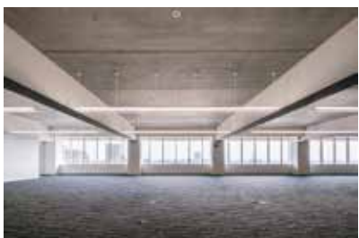
FR版現しの天井と上下配光導光板
