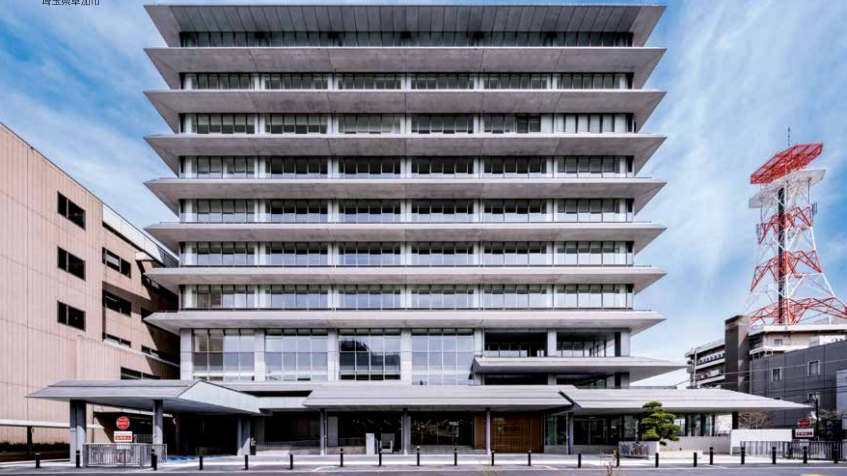
旧日光街道側外観
